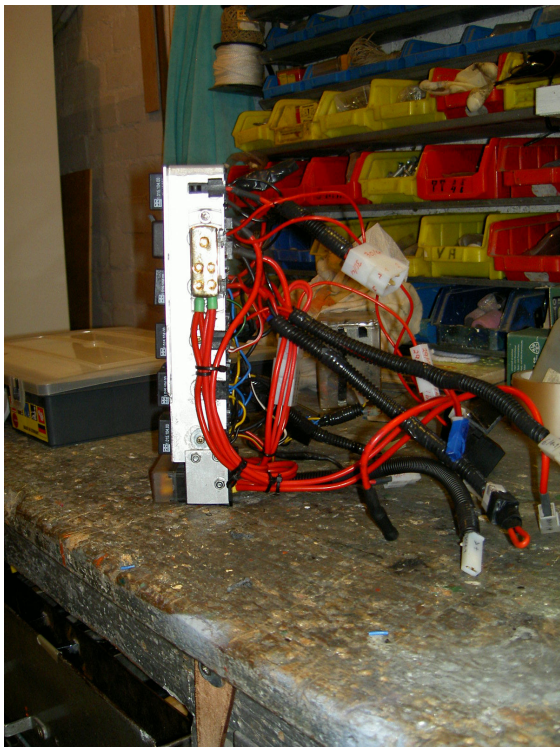
Seitenansicht Li. Relai-Schaltung mit Anschluss für Hauptstromleitung u. den Abgängen zum Sicherungskasten (Stromverteiler-Block, VB 1-4 7 1x20mm 2 / 4x10mm 2 / Conrad 36 69 35-33 4,95€ ) Alu-Winkel zur Befestigung der Relaissockel u zur Befestigung am Fahrzeug.
